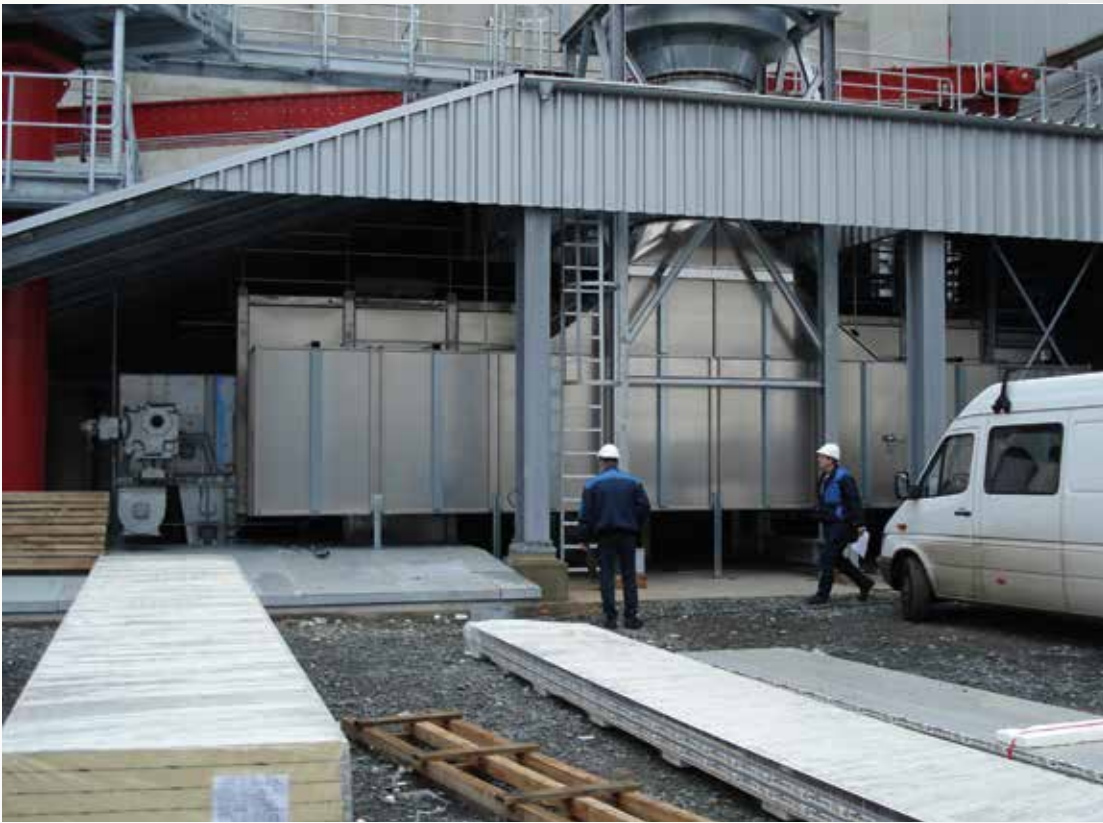
Projekt: UET Choren Deutschland Typ: BT 1/6200-12 Jahr: 2006 Produkt: Hackschnitzel Trocknerausgangsleistung: 4,5 t/h von 35% - 10% MC
